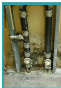
Identificación y mitigación de paneles de yeso con hongos previo a demolición
