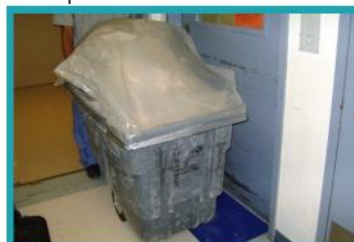
Remoción de material contaminado con hongos
