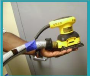
Uso de pulidora de masilla con aspiración HEPA
