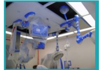
Protección de equipos durante las refacciones
