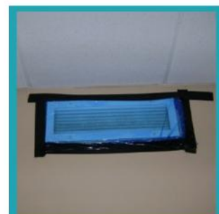
Sellado de rejillas de ventilación
